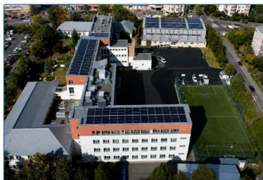
Fig. 38. – Sistem fotovoltaic clădiri educaționale – Municipiul Alba Iulia
