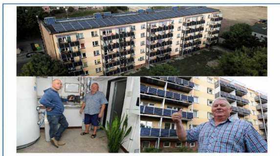
Fig. 28. – Sisteme fotovoltaice la bloc – proiect implementat în Polonia
