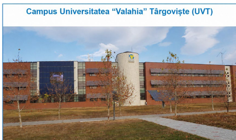
Fig. 47. – Clădire Institut Cercetări Multidisciplinare Târgoviște – cu posibilitatea de funcționare în regim insularizat
