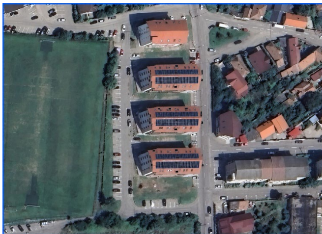
Fig. 30. – Sisteme fotovoltaice proiectate pe șarpantele unor blocuri de locuințe din Alba Iulia. Sursa: documentație tehnică, anul 2025, putere instalată 3x18 kWp, cu BESS
