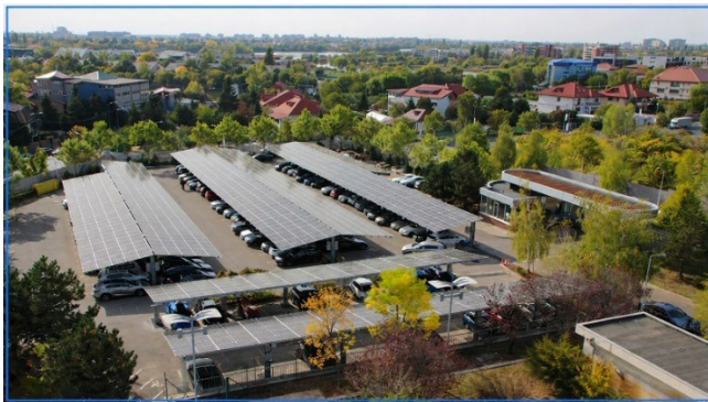
Fig. 65. – Prosumator industrial cu parcare fotovoltaică
