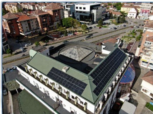
Fig. 37. – Sistem fotovoltaic clădire administrativă – Municipiul Alba Iulia
