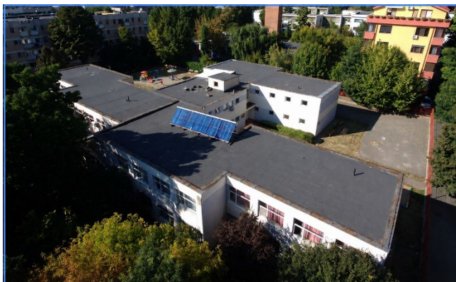
Fig. 55. – Sistem cu colectoare termice solare nefuncțional la o grădiniță
